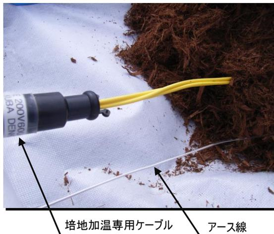
ベンチの材質が発泡スチロールなど電気的絶縁物の場合はアースが必要です。アース線は#21程度のステンレス線またはアルミ線
